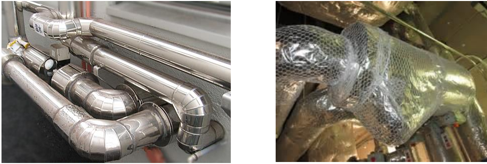
図 2-10 配管保温材の施工
